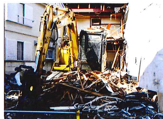
解体工事のイメージ
